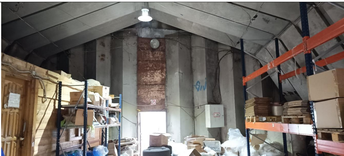
Фото 28. Нежилое здание общей площадью 266,9 кв.м. с кадастровым номером 77:06:0005005:1038, расположенное по адресу: г. Москва, ул. Болотниковская, д. 36Е, стр. 3.
