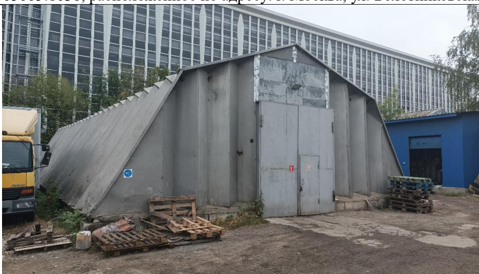
Фото 21. Нежилое здание общей площадью 266,9 кв.м. с кадастровым номером 77:06:0005005:1038, расположенное по адресу: г. Москва, ул. Болотниковская, д. 36Е, стр. 3.
