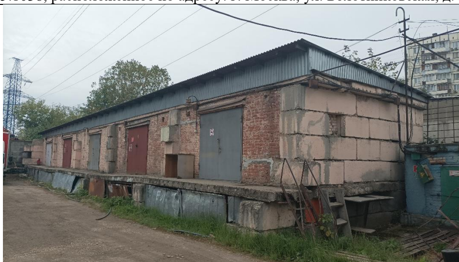
Фото 30. Нежилое здание общей площадью 163,3 кв.м. с кадастровым номером 77:06:0005005:1035, расположенное по адресу: г. Москва, ул. Болотниковская, д. 36Е, стр. 4.
