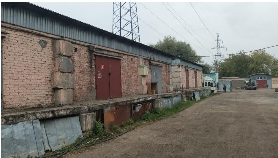
Фото 31. Нежилое здание общей площадью 163,3 кв.м. с кадастровым номером 77:06:0005005:1035, расположенное по адресу: г. Москва, ул. Болотниковская, д. 36Е, стр. 4.
