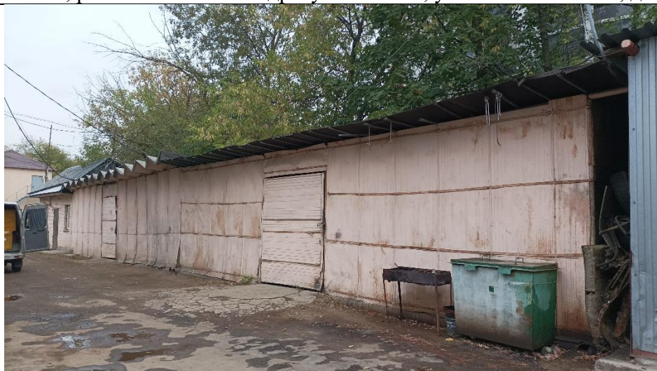
Фото 41. Нежилое здание общей площадью 132,1 кв.м. с кадастровым номером 77:06:0005005:1034, расположенное по адресу: г. Москва, ул. Болотниковская, д. 36Е, стр. 1.
