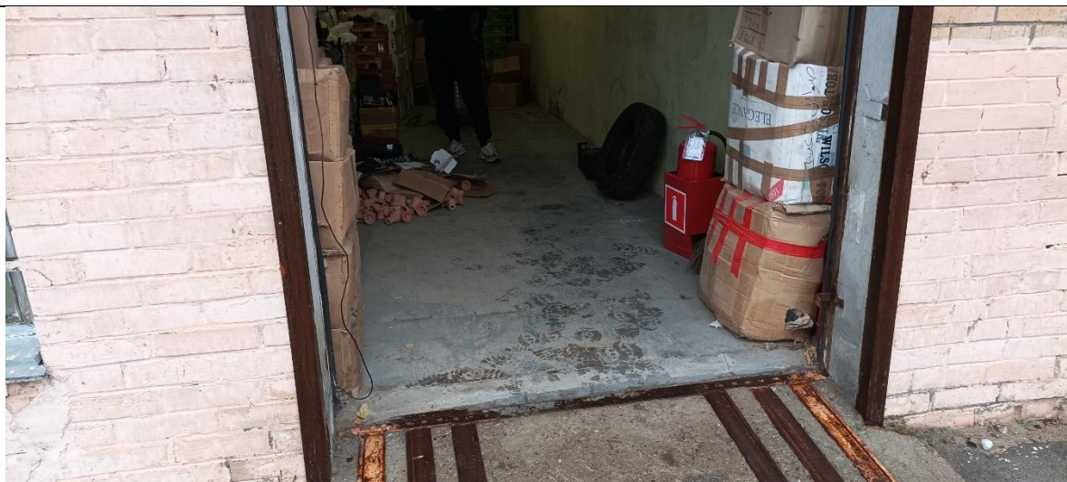
Фото 50. Первичные средства пожаротушения на объекте.
