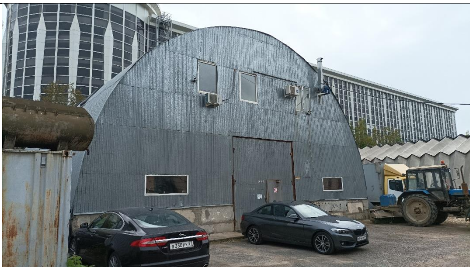
Фото 13. Нежилое здание общей площадью 507,8 кв.м. с кадастровым номером 77:06:0005005:1036, расположенное по адресу: г. Москва, ул. Болотниковская, д. 36Е.
