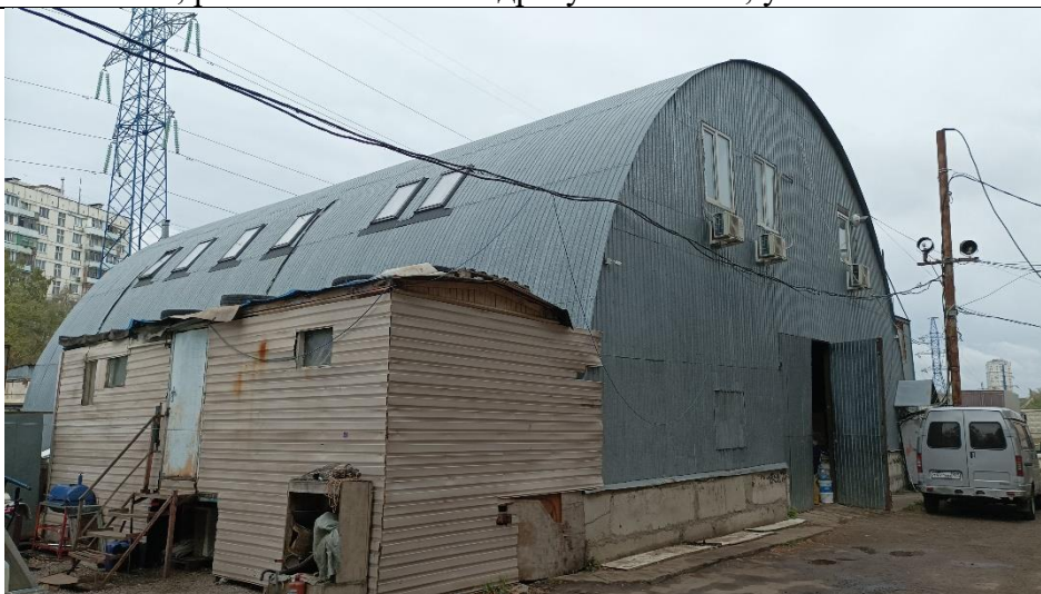
Фото 15. Нежилое здание общей площадью 507,8 кв.м. с кадастровым номером 77:06:0005005:1036, расположенное по адресу: г. Москва, ул. Болотниковская, д. 36Е.
