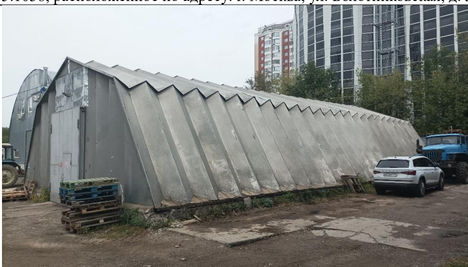
Фото 23. Нежилое здание общей площадью 266,9 кв.м. с кадастровым номером 77:06:0005005:1038, расположенное по адресу: г. Москва, ул. Болотниковская, д. 36Е, стр. 3.
