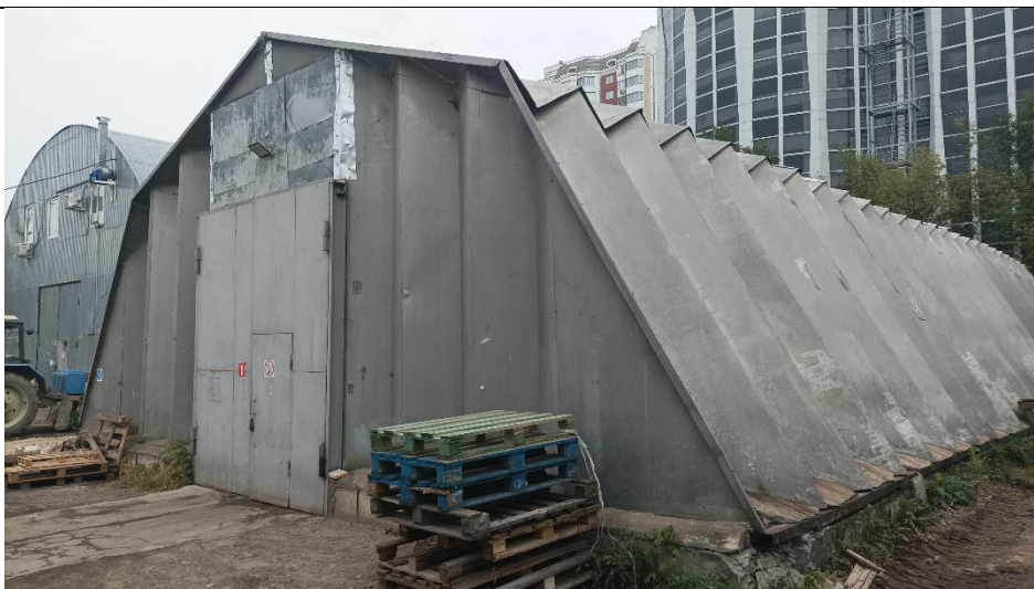
Фото 22. Нежилое здание общей площадью 266,9 кв.м. с кадастровым номером 77:06:0005005:1038, расположенное по адресу: г. Москва, ул. Болотниковская, д. 36Е, стр. 3.
