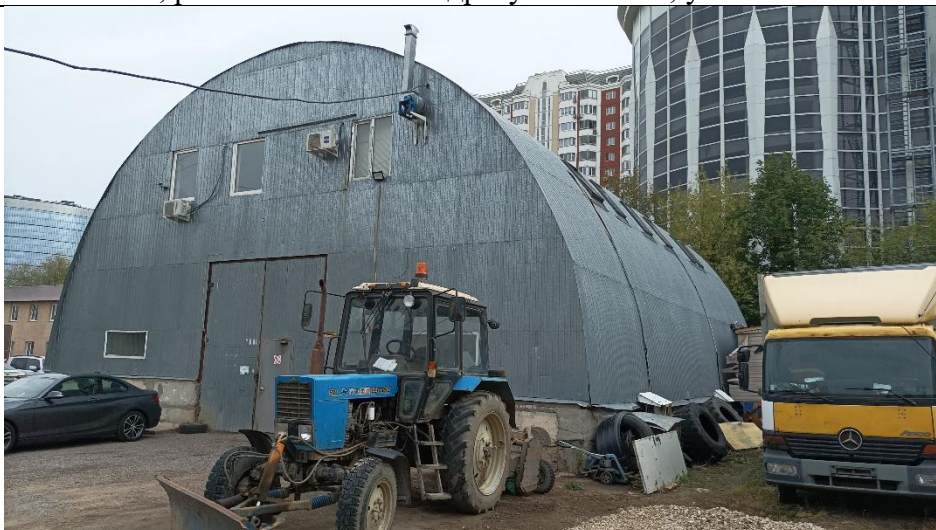
Фото 14. Нежилое здание общей площадью 507,8 кв.м. с кадастровым номером 77:06:0005005:1036, расположенное по адресу: г. Москва, ул. Болотниковская, д. 36Е.
