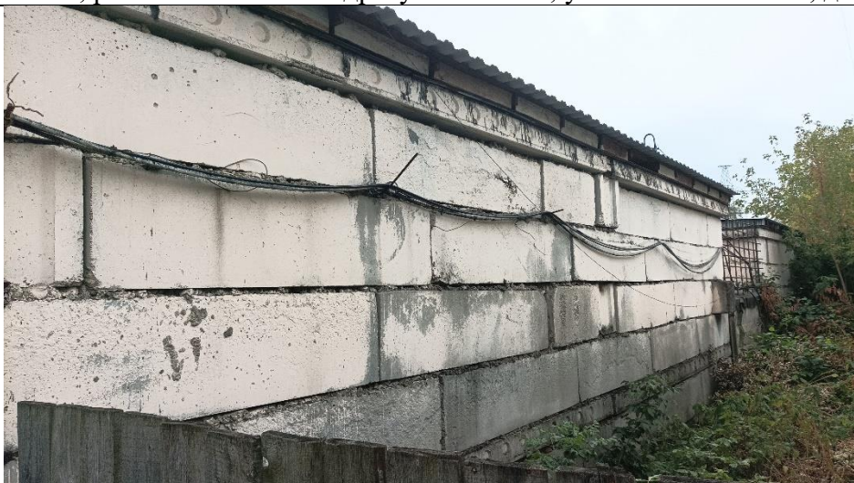
Фото 38. Нежилое здание общей площадью 57,8 кв.м. с кадастровым номером 77:06:0005005:1037, расположенное по адресу: г. Москва, ул. Болотниковская, д. 36Е, стр. 5.
