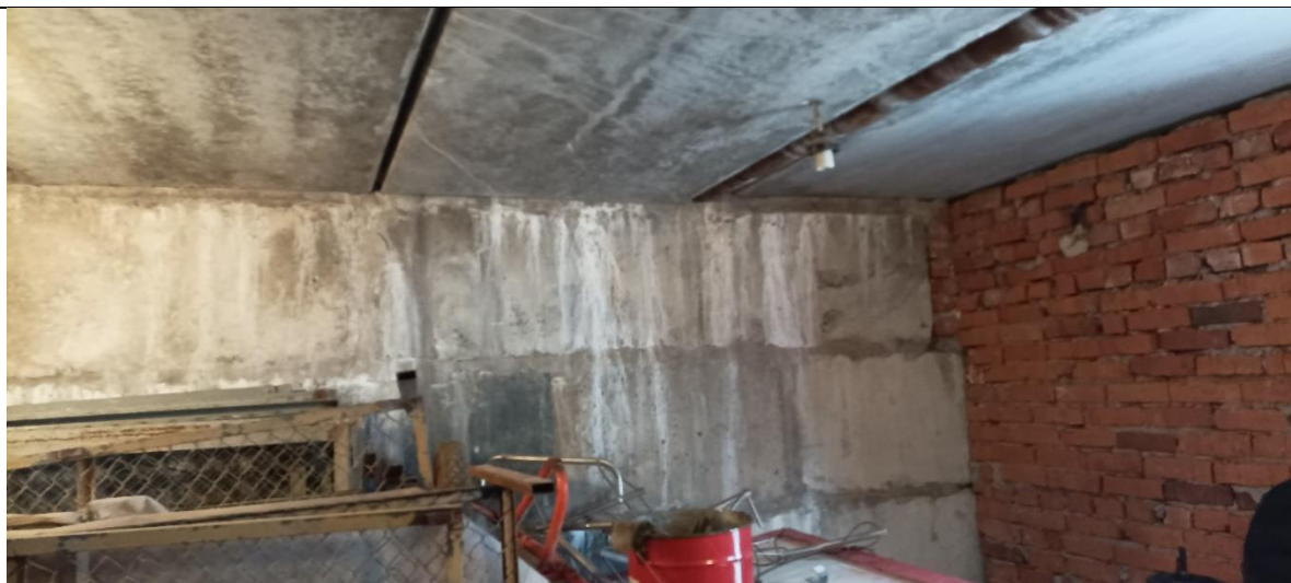
Фото 40. Нежилое здание общей площадью 57,8 кв.м. с кадастровым номером 77:06:0005005:1037, расположенное по адресу: г. Москва, ул. Болотниковская, д. 36Е, стр. 5.
