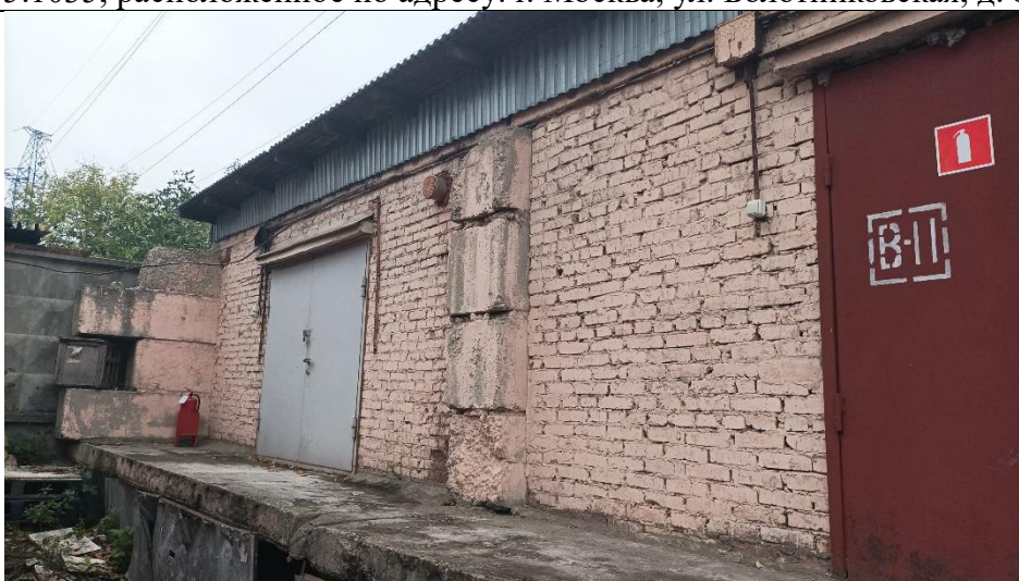
Фото 32. Нежилое здание общей площадью 163,3 кв.м. с кадастровым номером 77:06:0005005:1035, расположенное по адресу: г. Москва, ул. Болотниковская, д. 36Е, стр. 4.
