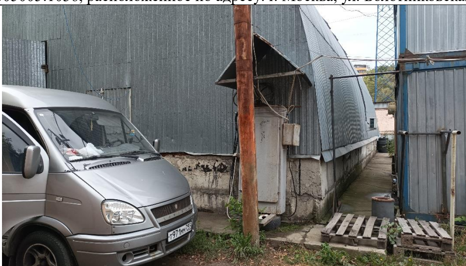
Фото 17. Нежилое здание общей площадью 507,8 кв.м. с кадастровым номером 77:06:0005005:1036, расположенное по адресу: г. Москва, ул. Болотниковская, д. 36Е.
