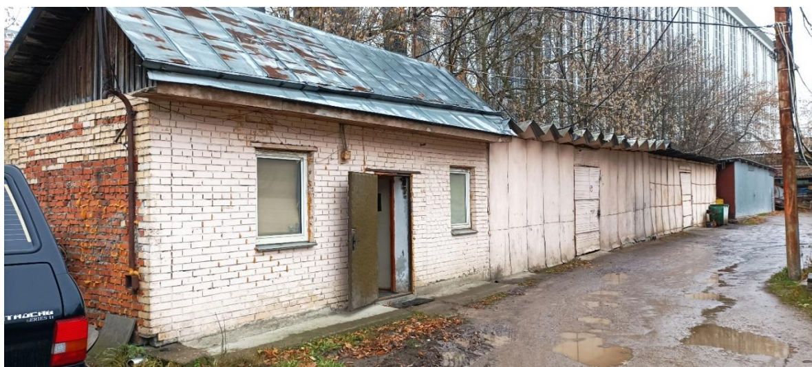
Фото 42. Нежилое здание общей площадью 132,1 кв.м. с кадастровым номером 77:06:0005005:1034, расположенное по адресу: г. Москва, ул. Болотниковская, д. 36Е, стр. 1.
