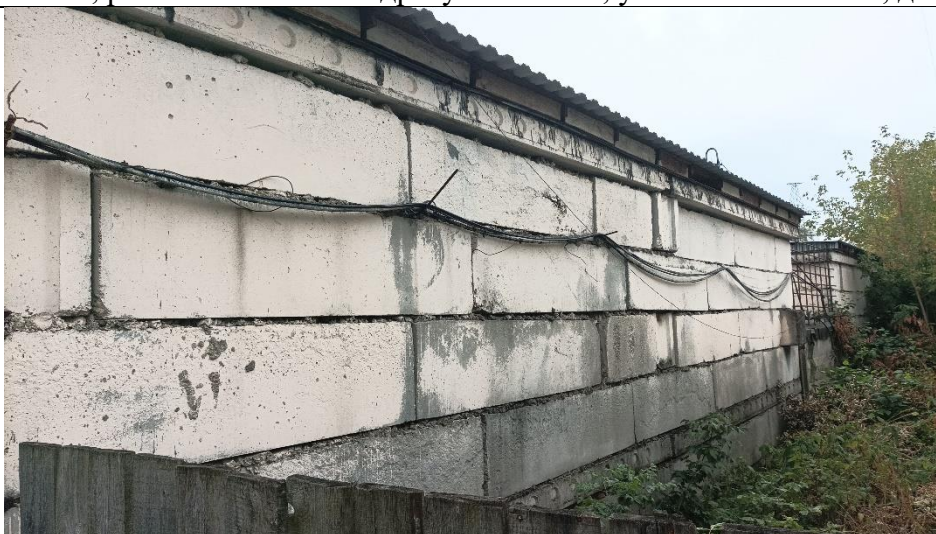
Фото 33. Нежилое здание общей площадью 163,3 кв.м. с кадастровым номером 77:06:0005005:1035, расположенное по адресу: г. Москва, ул. Болотниковская, д. 36Е, стр. 4.
