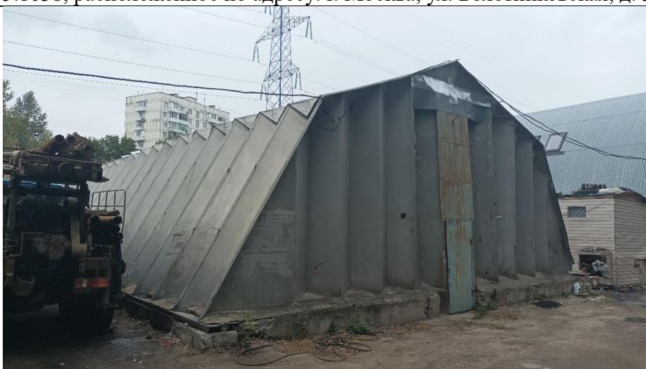
Фото 24. Нежилое здание общей площадью 266,9 кв.м. с кадастровым номером 77:06:0005005:1038, расположенное по адресу: г. Москва, ул. Болотниковская, д. 36Е, стр. 3.
