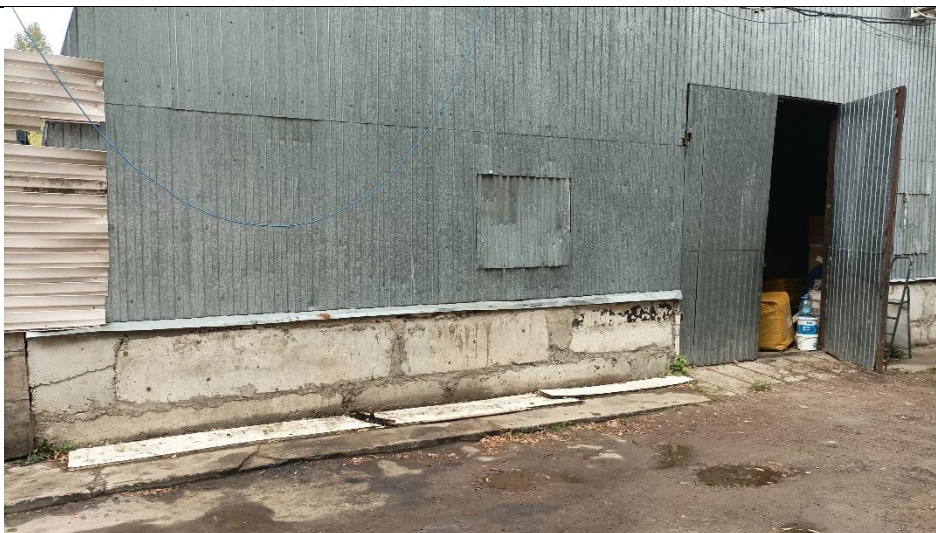
Фото 16. Нежилое здание общей площадью 507,8 кв.м. с кадастровым номером 77:06:0005005:1036, расположенное по адресу: г. Москва, ул. Болотниковская, д. 36Е.
