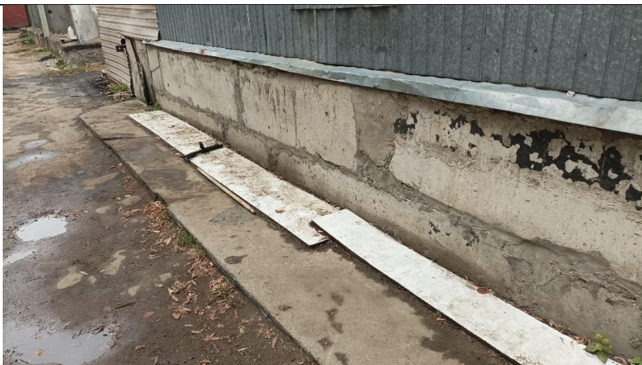
Фото 19. Нежилое здание общей площадью 507,8 кв.м. с кадастровым номером 77:06:0005005:1036, расположенное по адресу: г. Москва, ул. Болотниковская, д. 36Е.
