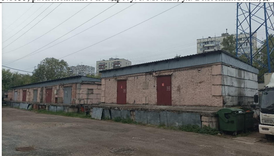
Фото 36. Нежилое здание общей площадью 57,8 кв.м. с кадастровым номером 77:06:0005005:1037, расположенное по адресу: г. Москва, ул. Болотниковская, д. 36Е, стр. 5.
