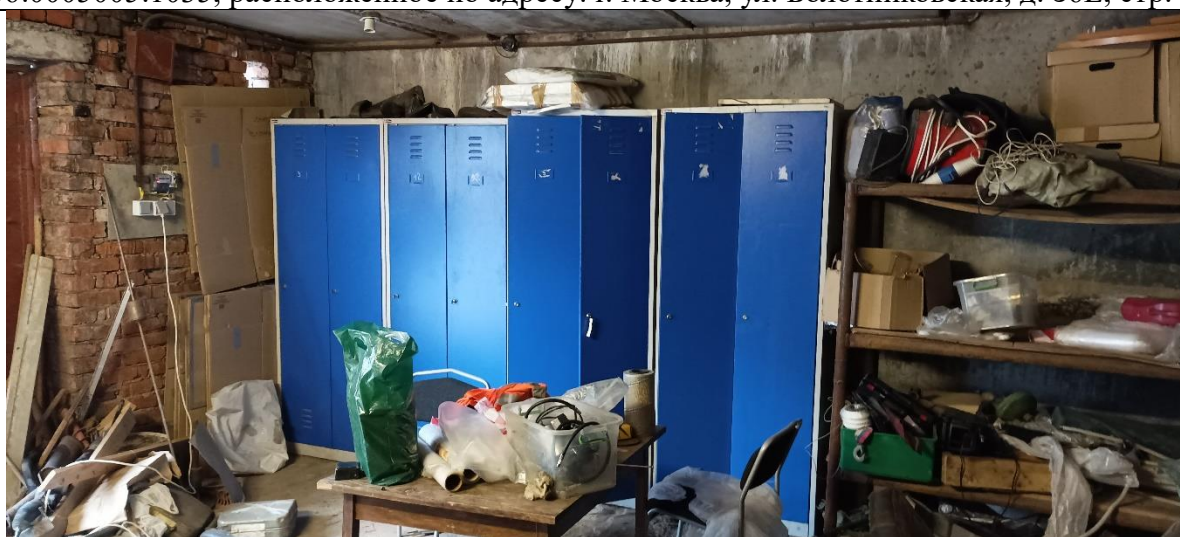
Фото 35. Нежилое здание общей площадью 163,3 кв.м. с кадастровым номером 77:06:0005005:1035, расположенное по адресу: г. Москва, ул. Болотниковская, д. 36Е, стр. 4.
