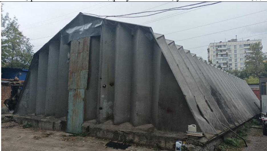
Фото 26. Нежилое здание общей площадью 266,9 кв.м. с кадастровым номером 77:06:0005005:1038, расположенное по адресу: г. Москва, ул. Болотниковская, д. 36Е, стр. 3.
