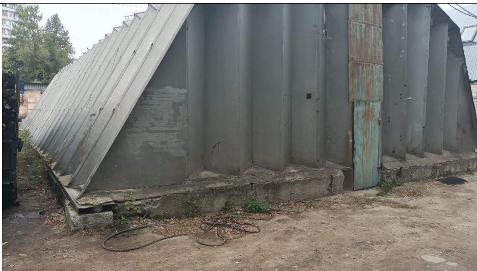
Фото 25. Нежилое здание общей площадью 266,9 кв.м. с кадастровым номером 77:06:0005005:1038, расположенное по адресу: г. Москва, ул. Болотниковская, д. 36Е, стр. 3.
