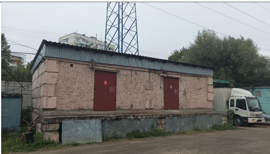
Фото 37. Нежилое здание общей площадью 57,8 кв.м. с кадастровым номером 77:06:0005005:1037, расположенное по адресу: г. Москва, ул. Болотниковская, д. 36Е, стр. 5.
